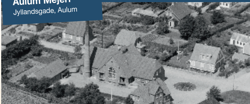
Aulum mejeri blev bygget i 1928 og lukkede i 1985. Bygningerne blev revet ned i 2014.
